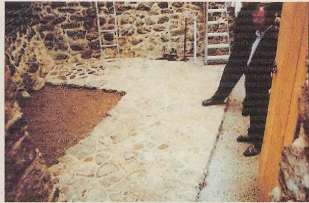
Mauereck im "Dohlenturm"
